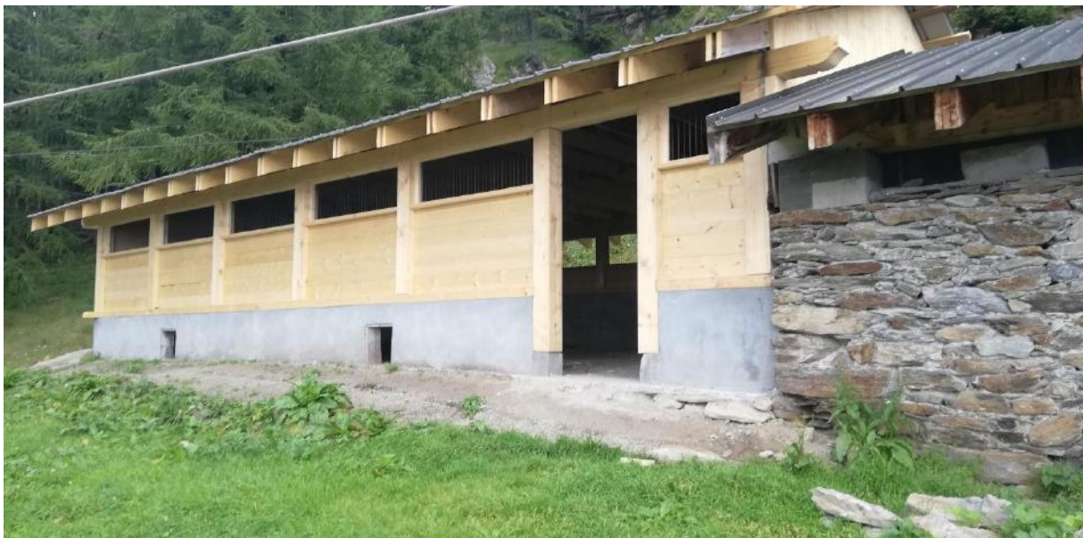
La construction de la chêvrerie au cours de l'été
