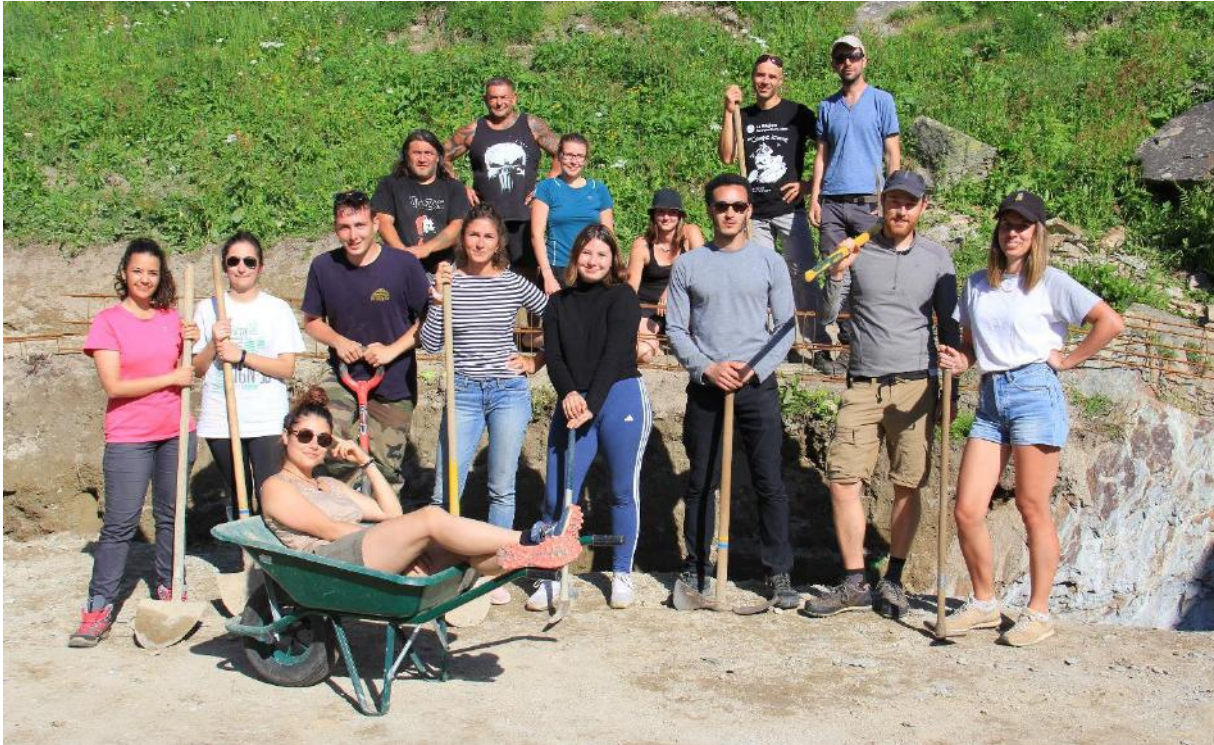
Photo de fin de chantier, on reconnaît facilement les 2 maçons professionnels, les biceps ne sont pas de même taille !
